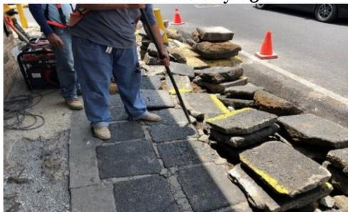
*En la imagen anterior se puede observar cómo se utiliza la barra metálica como palanca para sacar la piedra de forma manual y sin golpearla.*
