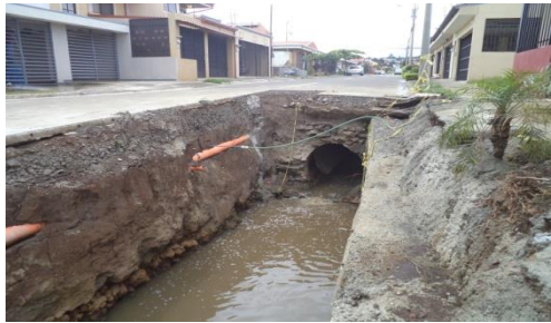
Foto 7: Vista de entubamiento de quebrada en Residencial Jerez.
