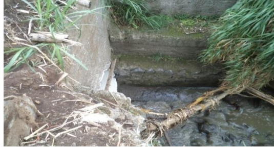
Foto 6: Vista de quebrada Aries en su entubamiento en Residencial Jerez.
