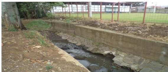
Foto 4: Vista del canal quebrada Aries en la Urbanización Los Cafetos
