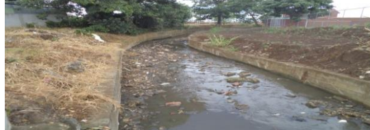
Foto 3: Vista del canal quebrada Aries en la Urbanización Los Cafetos.
