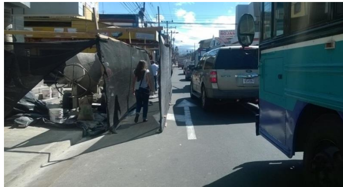
Imagen #9 Paso peatonal habilitado, Banco Nacional
