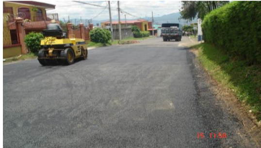
BACHEO URBANIZACION LA CORNELIA
