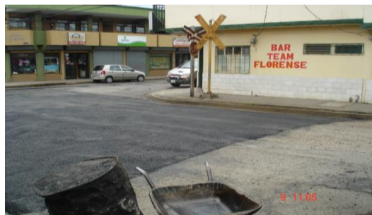
BACHEO EN CALLE 10 HEREDIA CENTRO
