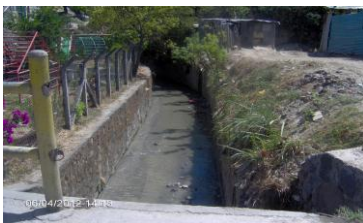
Encausado de las aguas para evitar contaminación
