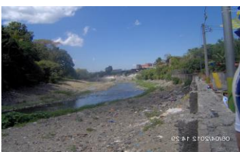
Río Acelhuate después de la intervención
