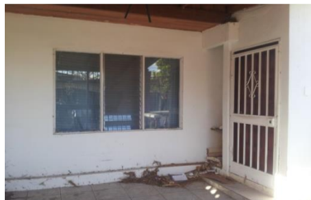
Ilustración 3: Condición exterior de la estructura
