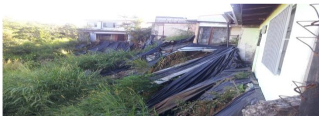
Ilustración 6: Vista parte trasera de las viviendas
