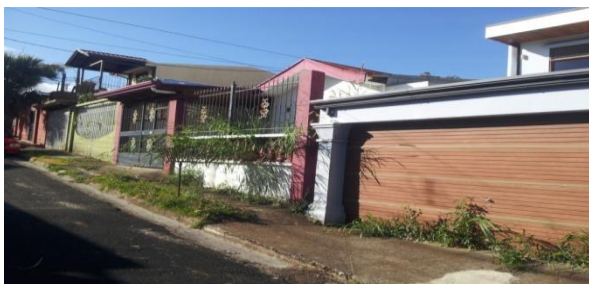
Ilustración 4: Colindancias del inmueble en su parte frontal
