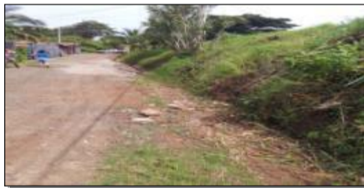
Fotografías 4, 5, 6 y 7 La calle pública se encuentra en tierra y carece de cunetas o caños a ambos lados; posee aceras parcialmente en uno de sus costados.
